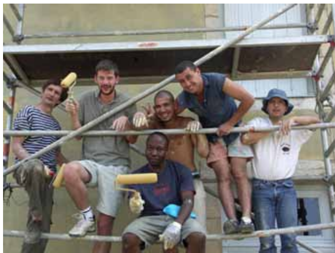
Camp chantier d'Arcelot
